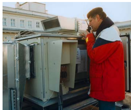
Einregulierung der Lüftungstechnik
