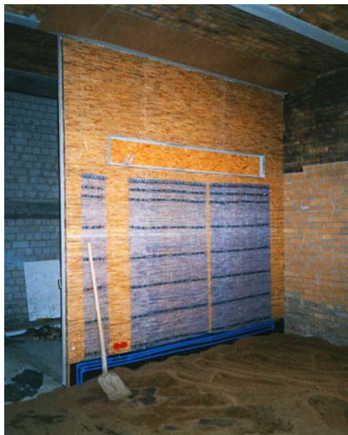
Wandaufbau mit Heizmatten
