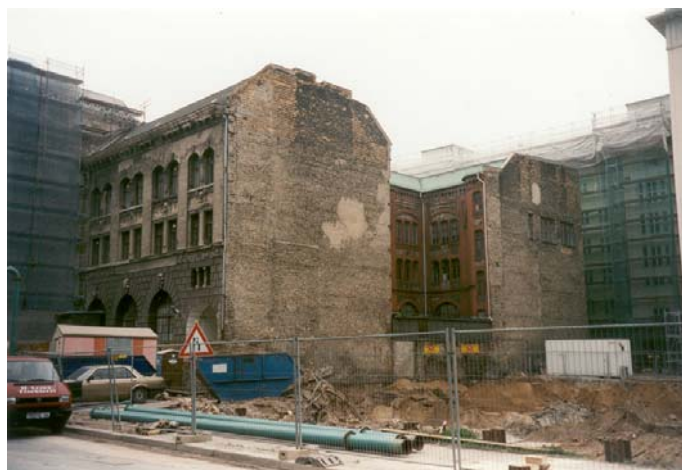
Das Gebäude vor Baubeginn, Foto: k+p 1996
