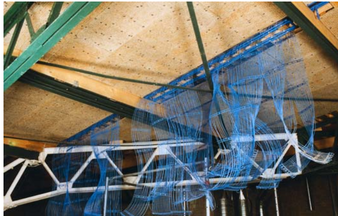
Deckenheizung im DG
