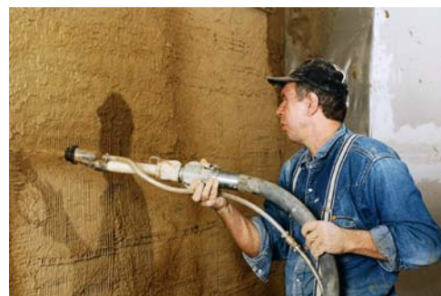
Maschineller Auftrag des Lehmputzes
